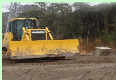
現場でのがれき撤去訓練の様子
